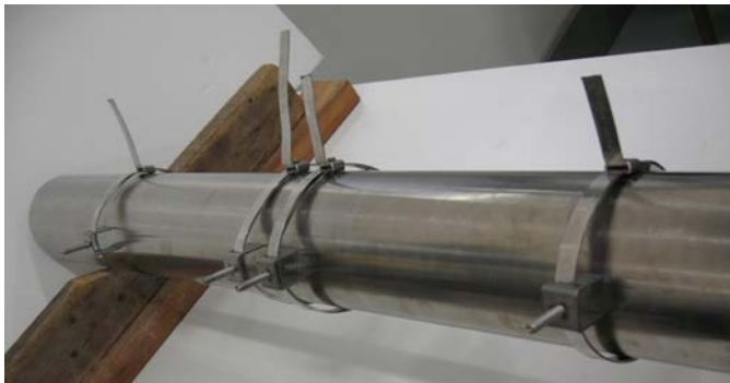
Bild B-31 Installation der Abstandsbügel und Montagebänder
